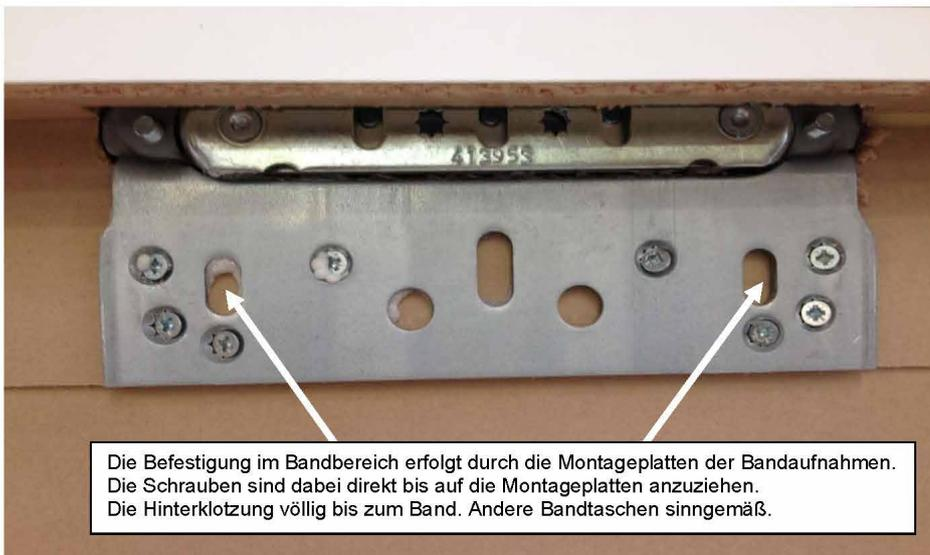
Die Befestigung im Bandbereich erfolgt durch die Montageplatten der Bandaufnahmen. Die Schrauben sind dabei direkt bis auf die Montageplatten anzuziehen. Die Hinterklotzung völlig bis zum Band. Andere Bandtaschen sinngemäß.
